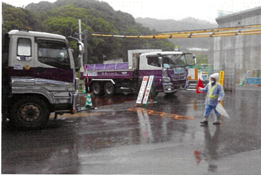
車輛出入口に交通誘導員と ゴム製丸型の一旦停止表示設置
