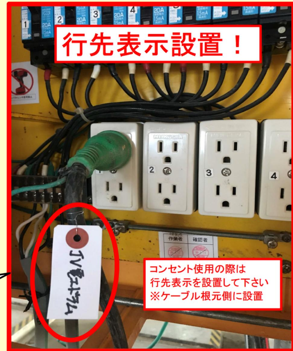
仮設分電盤使用時に行先表示設置を徹底させるため、分電盤使用時に確実に目に入る盤面に行先表示の設置例を表示した
