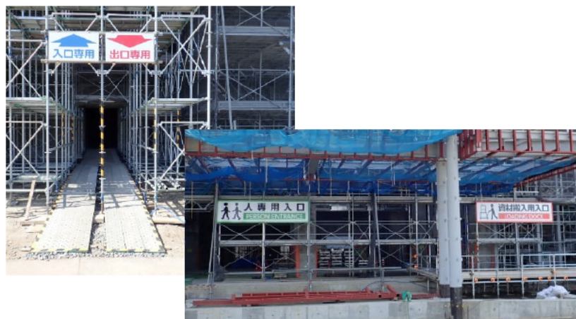
④歩車・動線分離による接触事故防止の取組 【作業通路の一方通行可、人員通路と搬入動線の分離】
