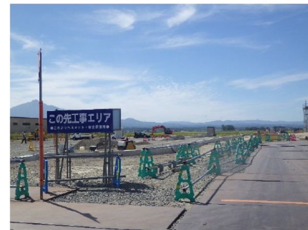
③工事エリアとノーヘルゾーンの明確化 歩道と車道の分離 【区画線引きと、看板・歩道の設置】
