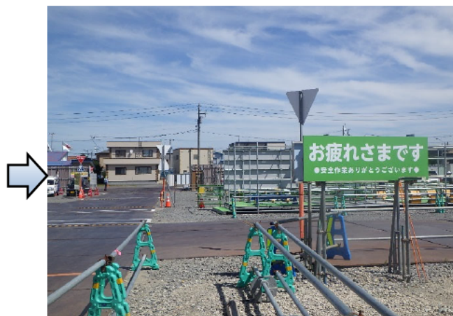
⑤作業員ストレス緩和の取組 【退場経路に声掛け看板の設置】
