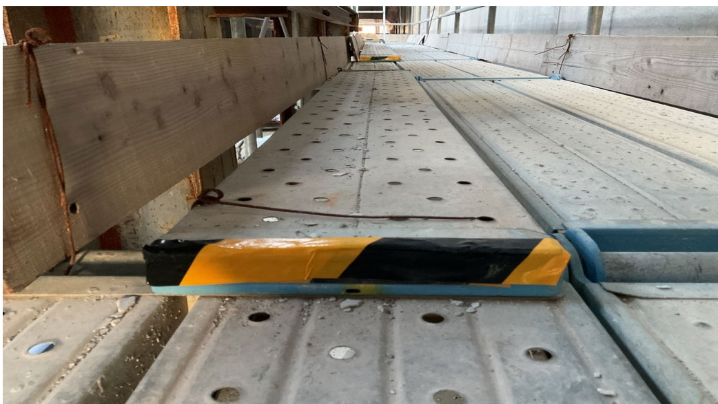
足場板の重ね部の明示
