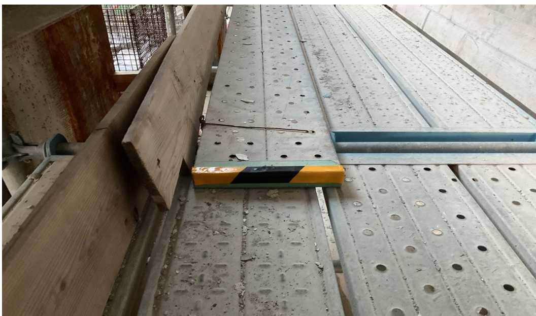
足場板の重ね部の明示
