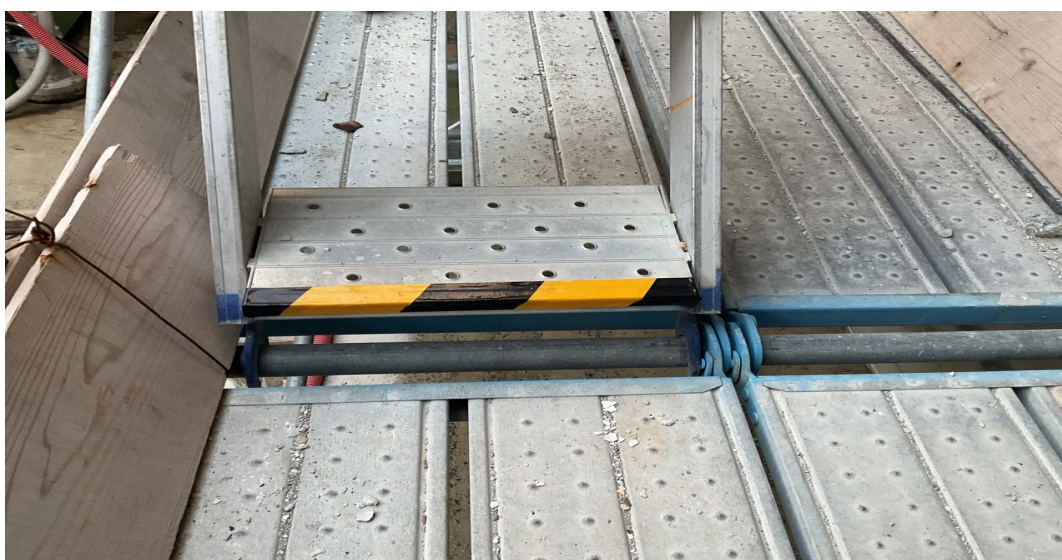
階段枠の明示（始点・終点）
