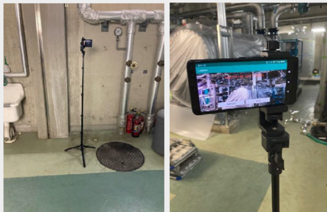
現場設置カメラ
