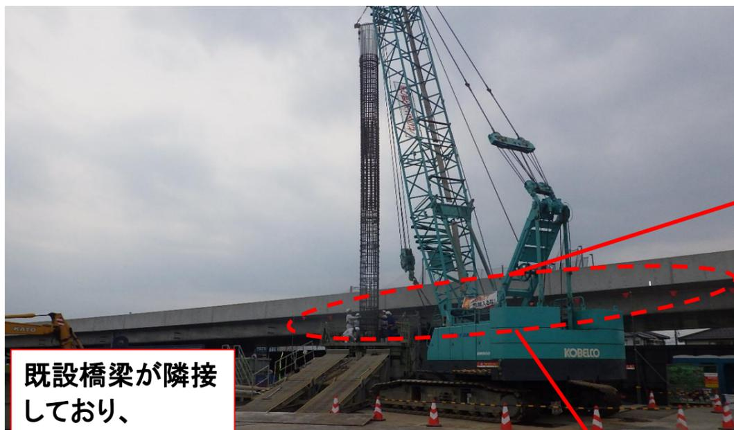
既設橋梁が隣接しており、クレーンが接触する可能性あり
