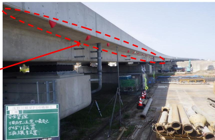
・既設構造物が隣接している場所で施工しているため、重量物を吊ったクレーンによる構造物接触防止を明確化した。
