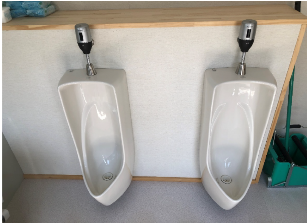
(2) トイレの自動水栓導入（接触防止）
