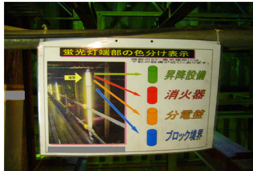
坑内安全通路上の説明用標識
