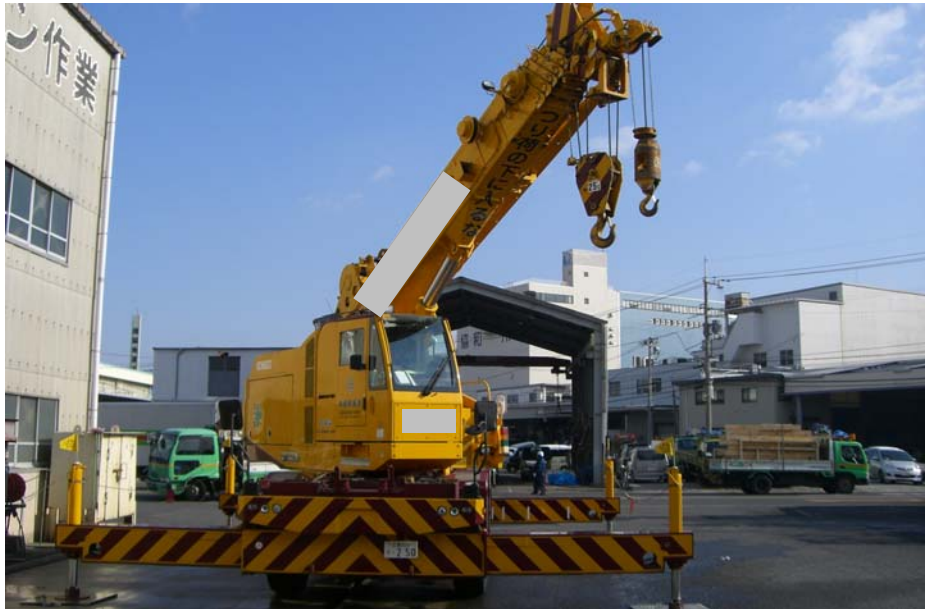
クレーン設置状況
