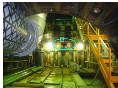
全景 (シールド坑内から望む)
