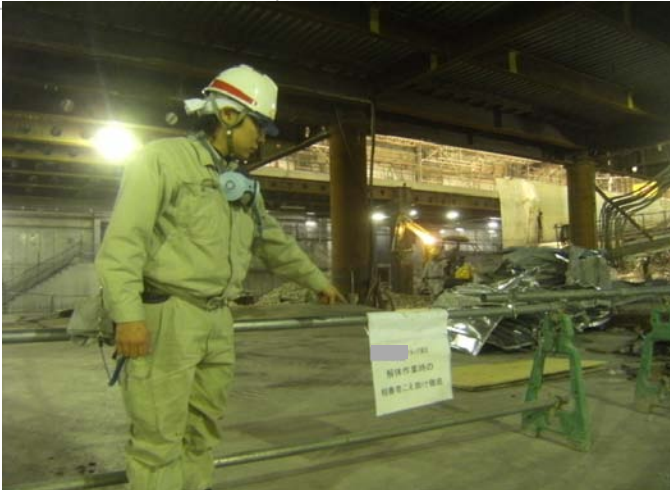
解体作業時の 相番者こえ掛け確認表示
