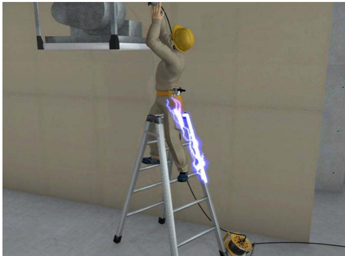
点検不良の電工ドラムから漏電し感電
