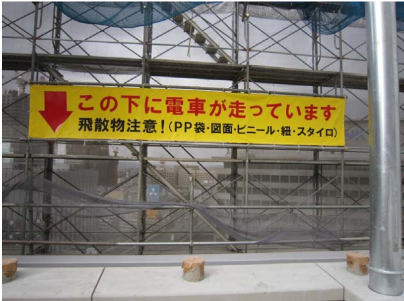
現場屋上にて、看板設置状況
