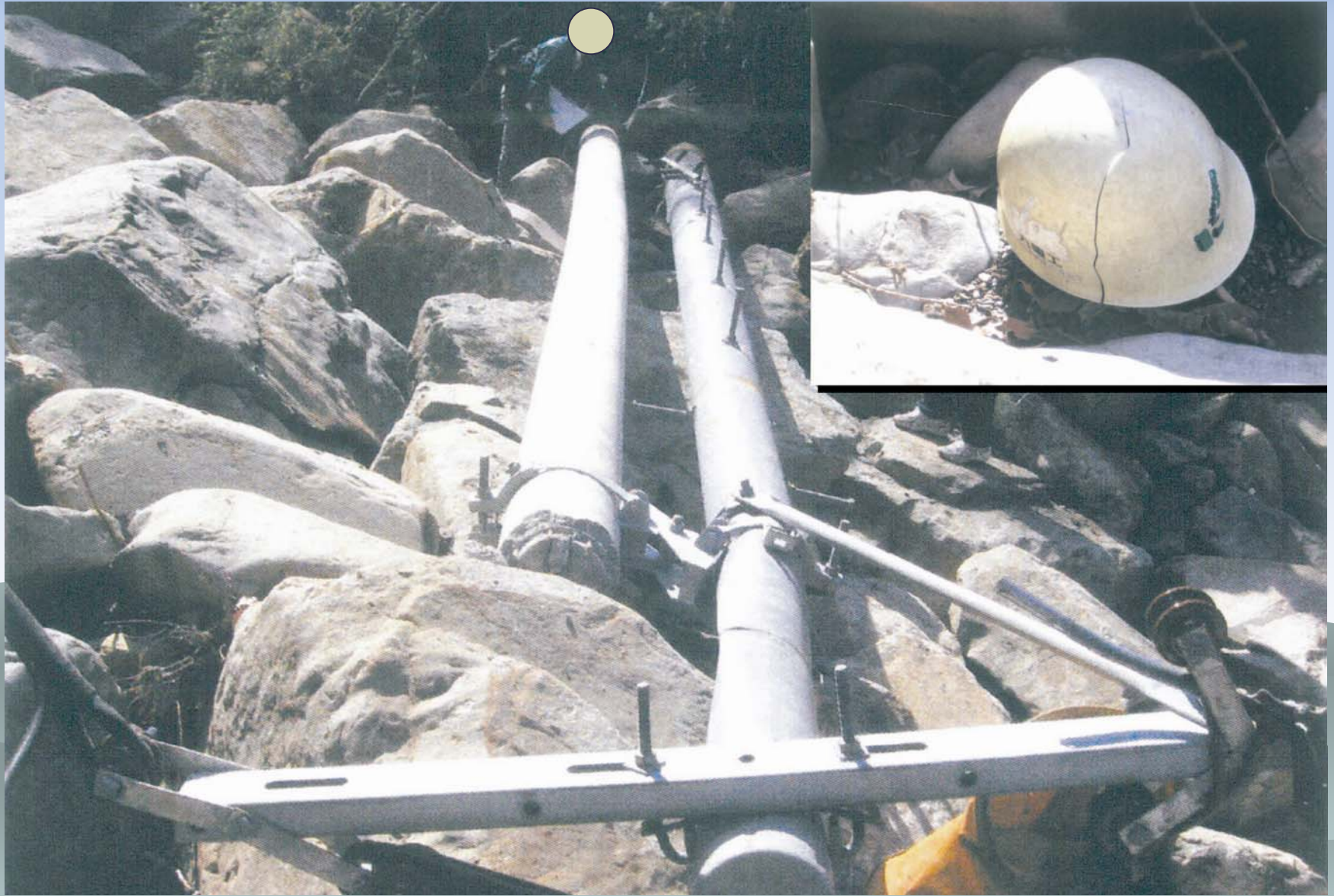
【「電柱倒壊死亡災害現場」のパネル展示】
