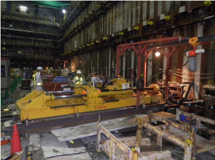
水平削孔機 全景
