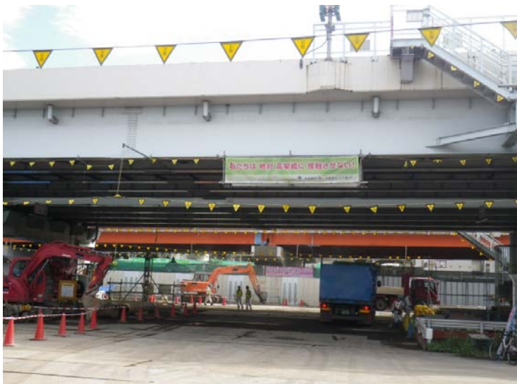
③道路桁表示の2重三角旗(近接防止)
