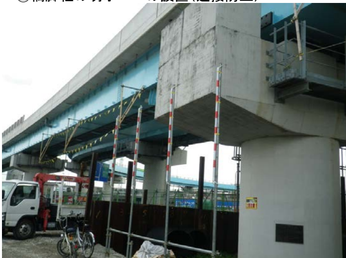
③道路桁表示の2重三角旗(近接防止)
