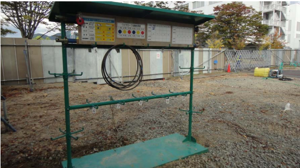
(ワイヤー管理ラック 全体写真)
