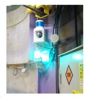
吊荷近接時のフラッシュライトの点滅 坑内作業では騒音作業時などで耳栓等を着用している場合がある。その ため立坑の荷揚げ・荷卸し時に、吊荷に気が付かずに接触する危険性が ある。
