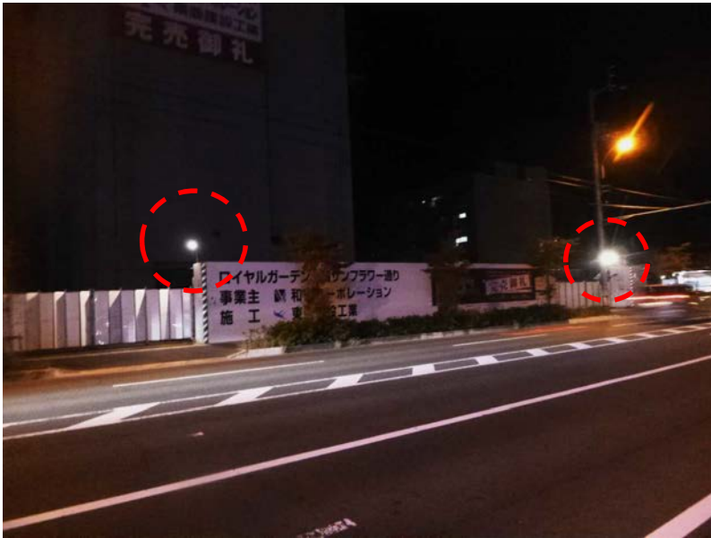
⑥-1 人感センサー感知による照明点灯状況 (ゲート2カ所全景)
