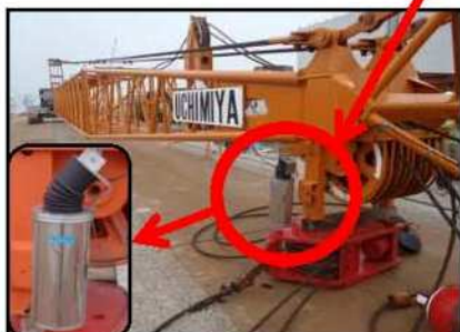
クレーンカメラ取付 状況②
