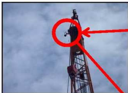
クレーンカメラ取付 状況①
