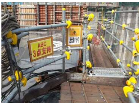
現場掲示例(3点支持)
