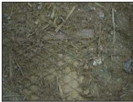
法面保護のラス網
