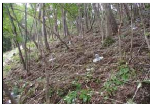
法面保護のラス網
