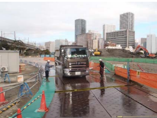
搬出車両タイヤ洗浄状況
