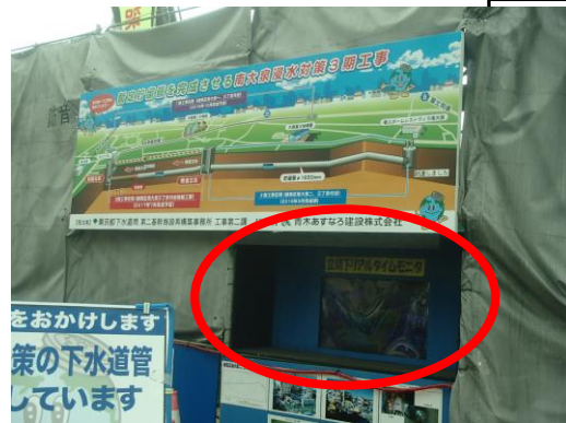
立坑下モニター
