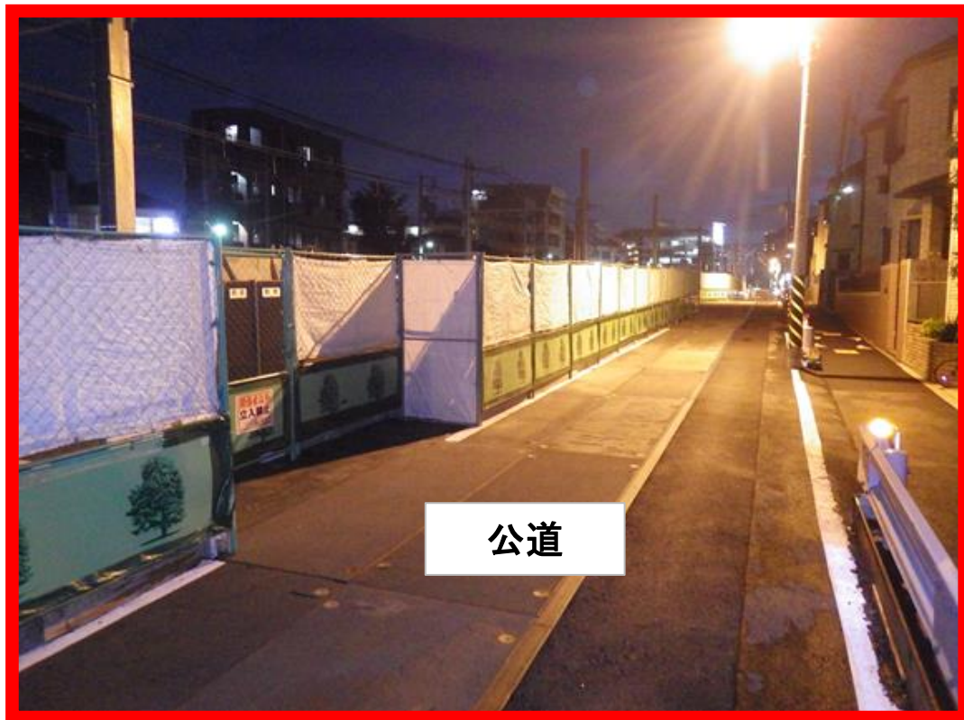
一般道側待避箇所
