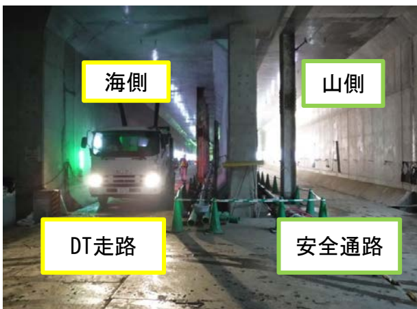
写真-緩行線トンネル DT走路と安全通路の区分状況
