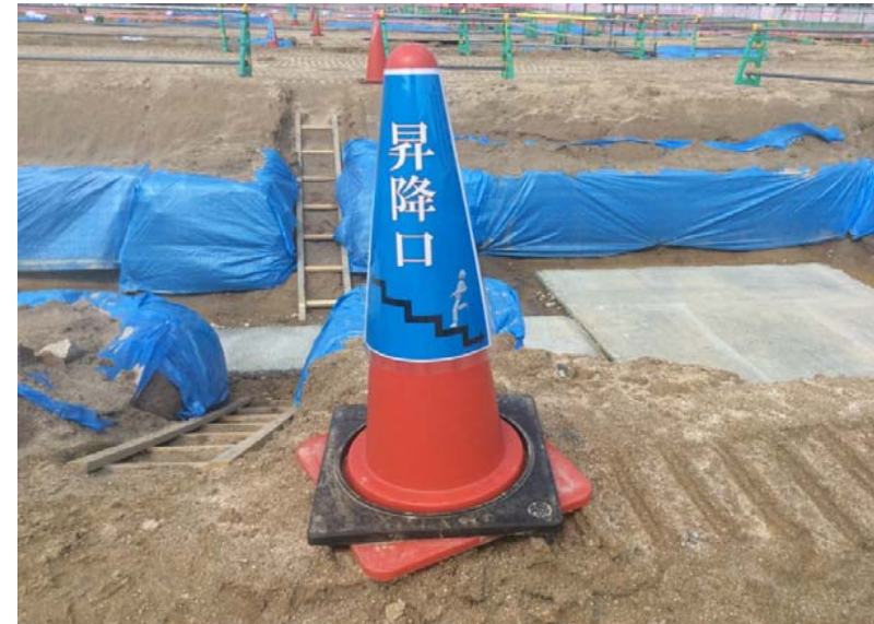
現場の昇降スロープの位置表示 ※青色 & イラスト入りにて表示
