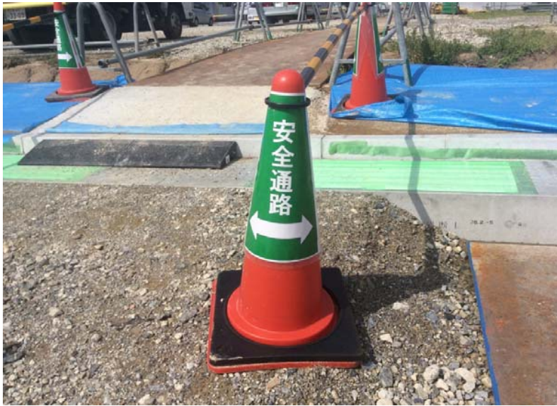
安全通路表示に使用(安全通路は緑色が背景) ※虎バーが表示の抑えの役割も担う
