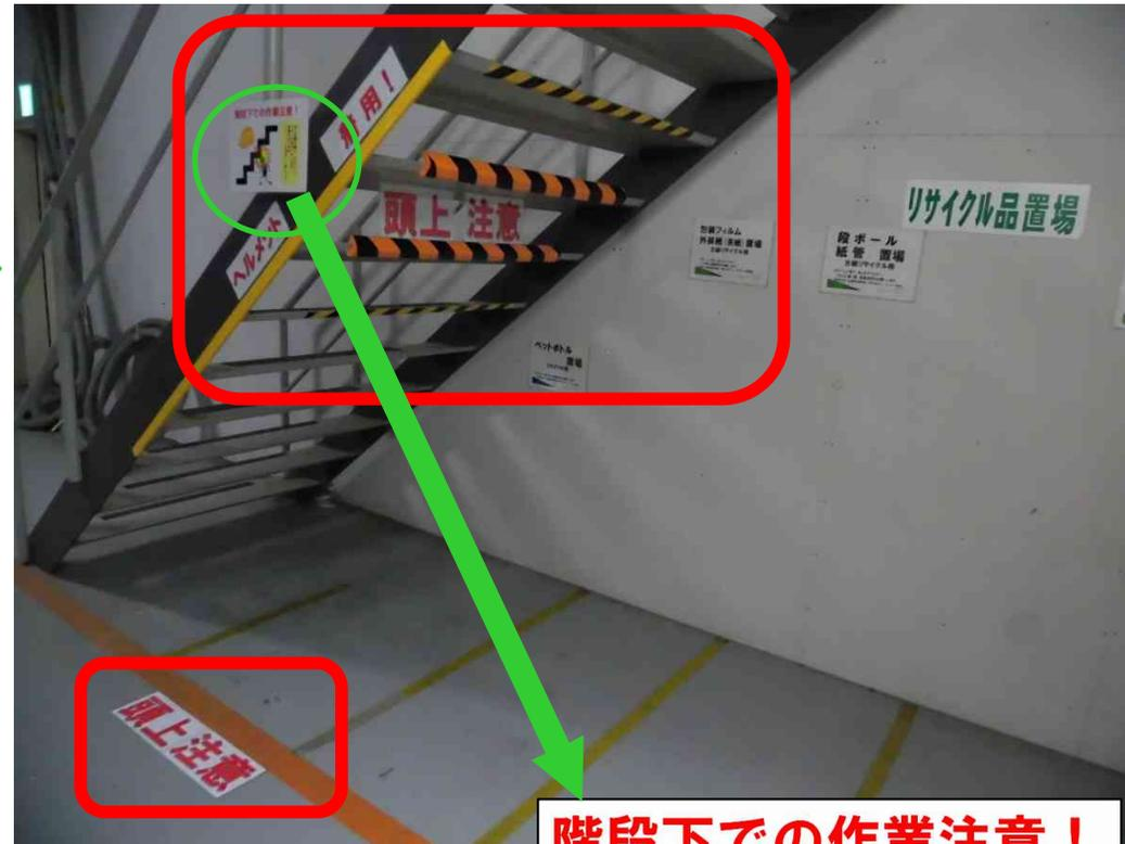
階段下のスペースを有効活用するために利用しますが、頭部を打って打撲などケガの危険がありますので、注意を促すために注意表示と頭を打つ可能性のある場所に、コーナガードのクッションを貼り付けています。また、姿勢がかがみ、視線が落ちるので、床面にも注意表示をおこなっています。
