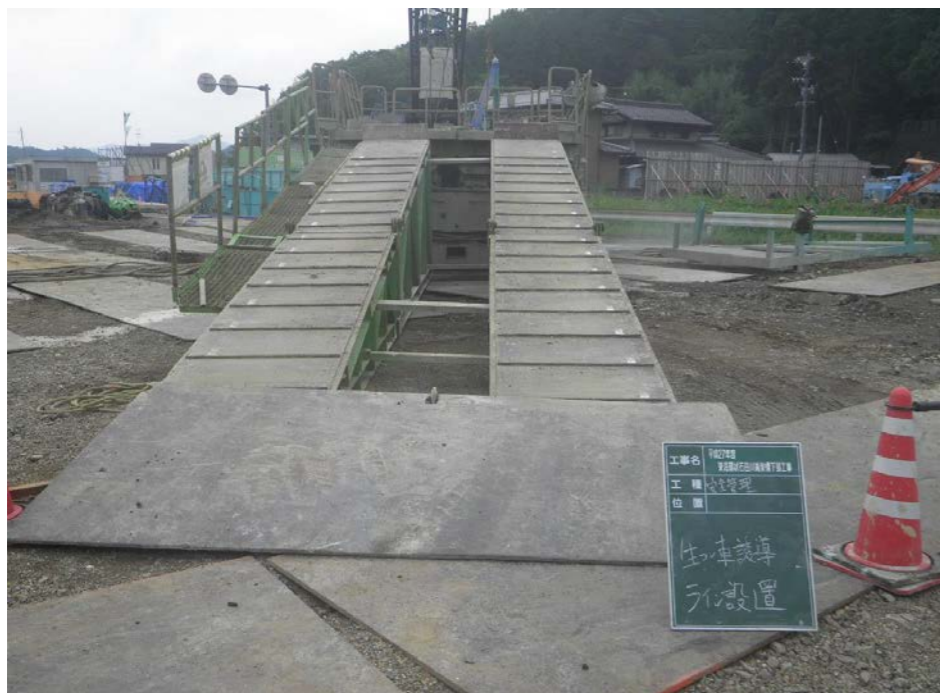
生コン車スロープに走行線表示
