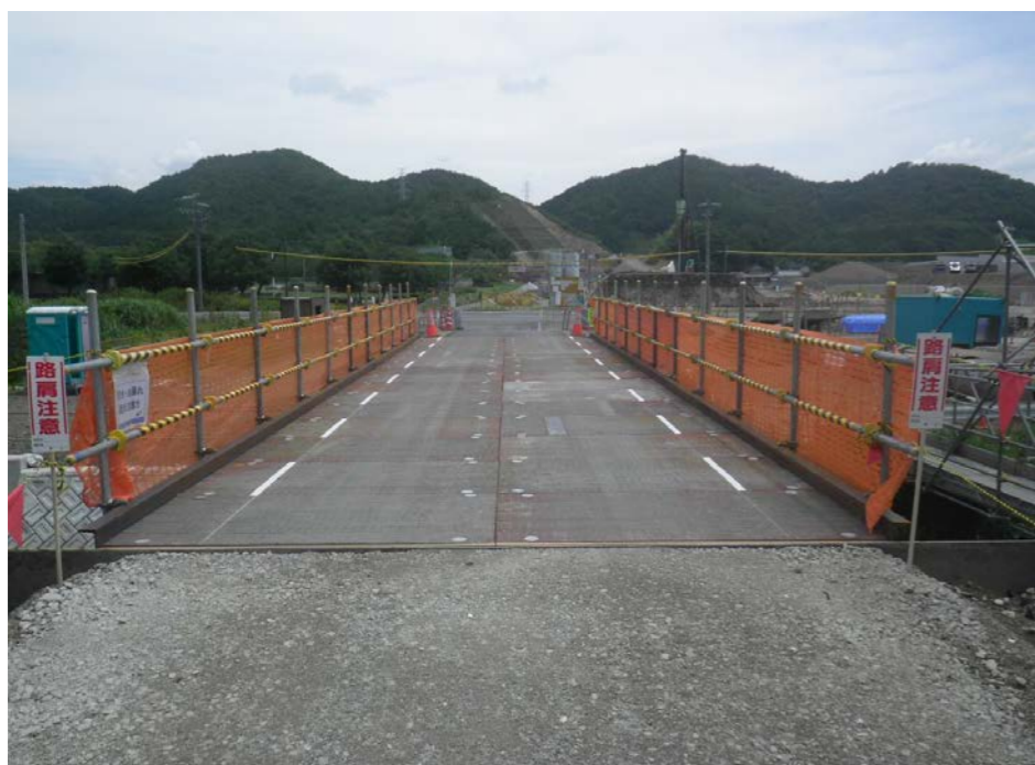
工事用道路仮橋に走行線表示
