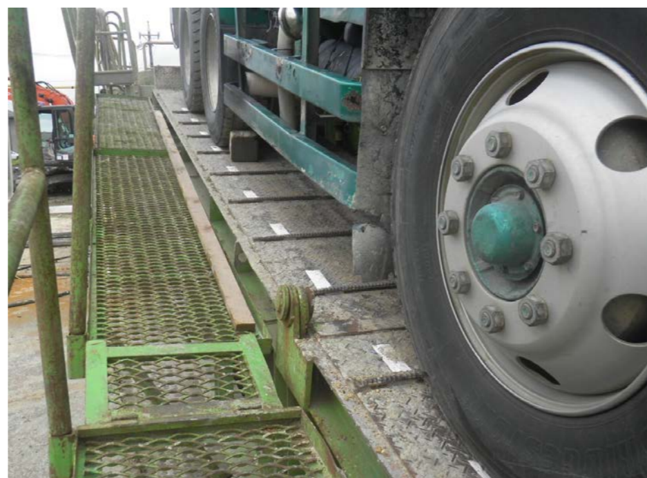
生コン車スロープに走行線表示
