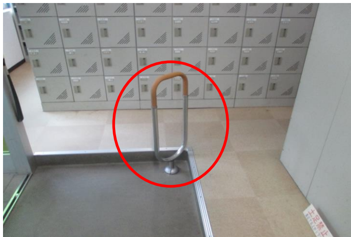
工場棟出入口 靴履き替え箇所の手摺り
