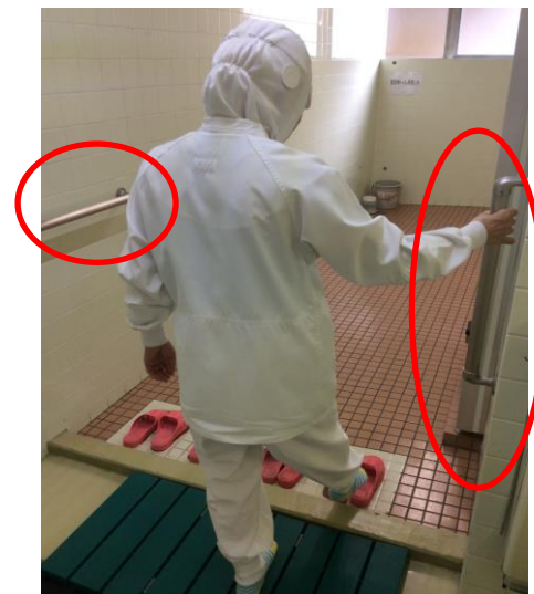
お手洗いスリッパ履き替え箇所の手摺り
