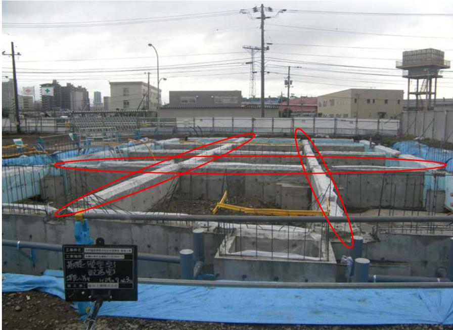
埋戻し前：地中梁上端フカシ筋にポリフィルム養生
