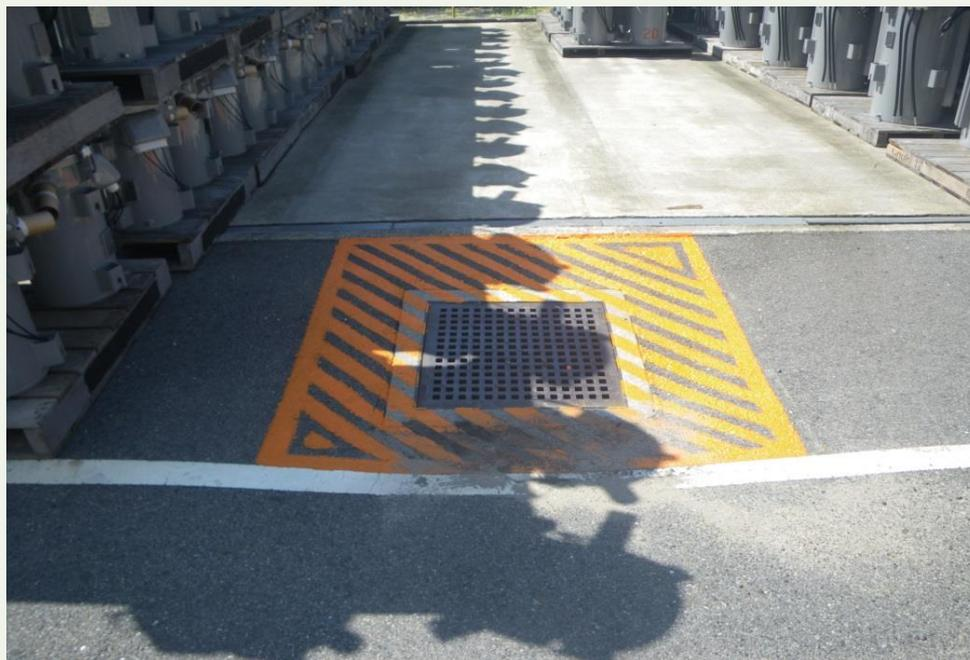
路面の傾いている(凹み)箇所に製品(変圧器)を置かないように注意標示をした。また、製品を運搬するフォークリフトの走行時にも傾き箇所が視覚的に分かる。
