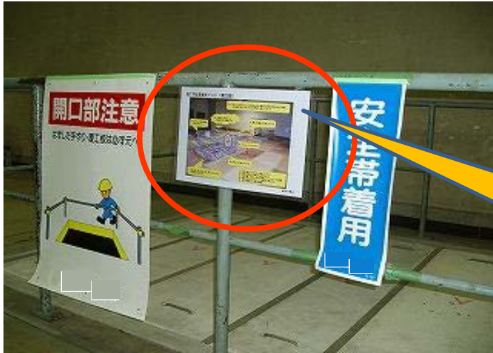
現場の危険箇所に掲示
