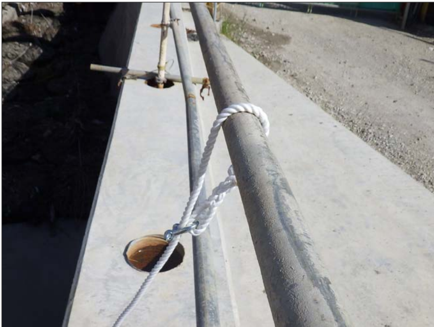
工種:創意工夫 種別:河川作業 写真タイトル:ロープ固定
