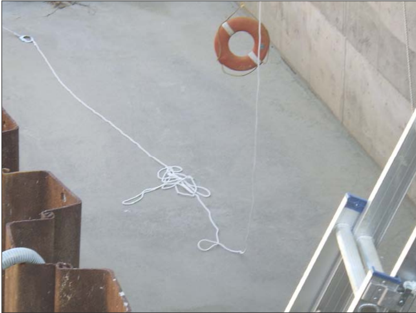
工種:創意工夫 種別:河川作業 写真タイトル:浮き輪設置
