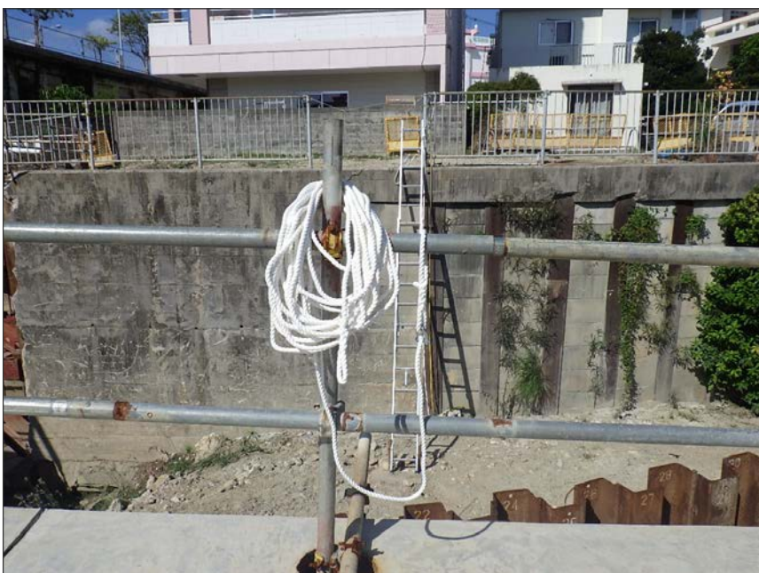
工種:創意工夫 種別:河川作業 写真タイトル:作業時におけるロープ
