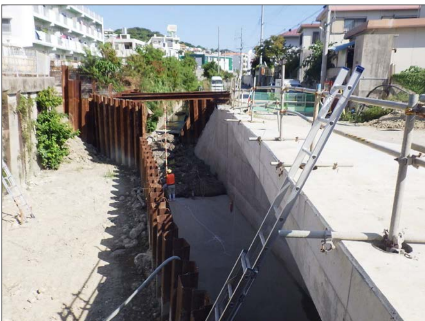
工種: 創意工夫 種別: 河川作業 写真タイトル: ロープによる安全対策
