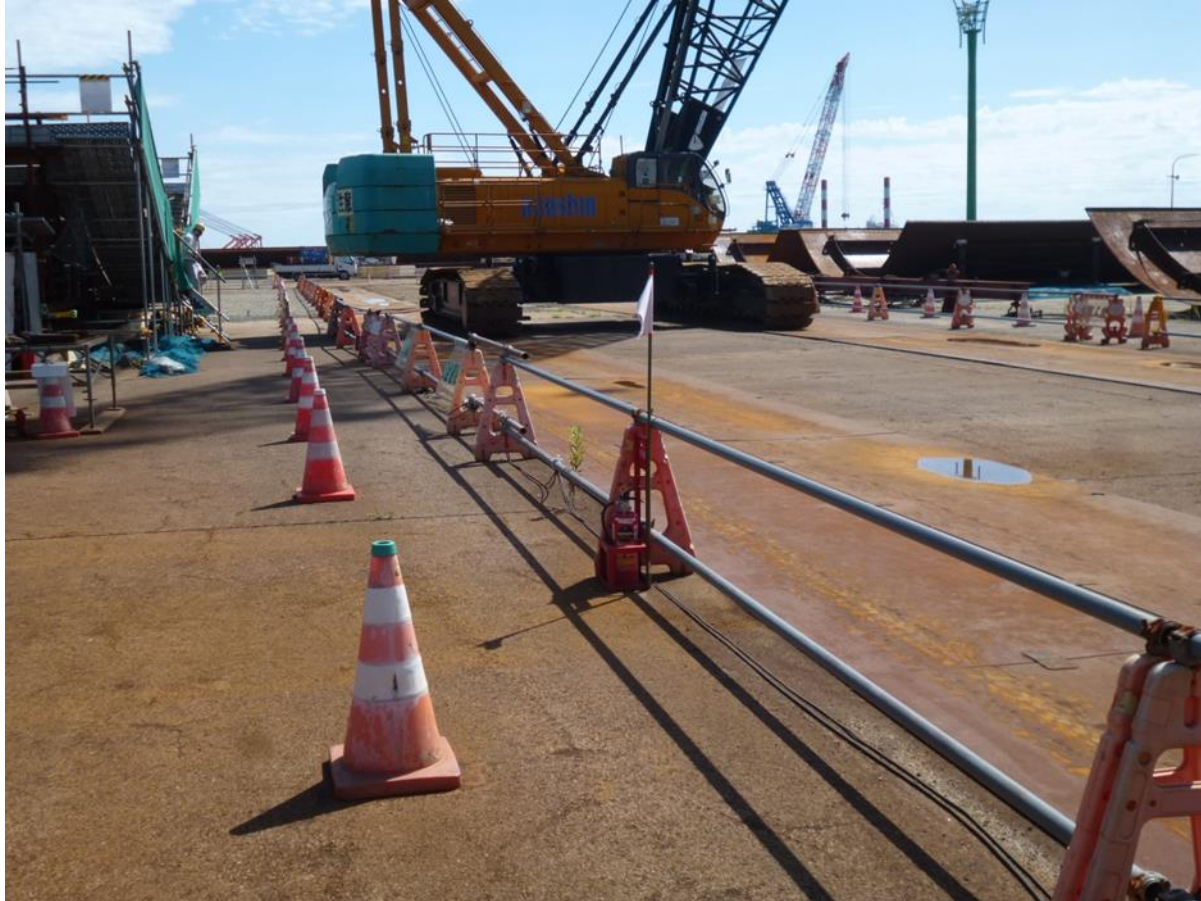
セル・アーク製作ヤード全景
