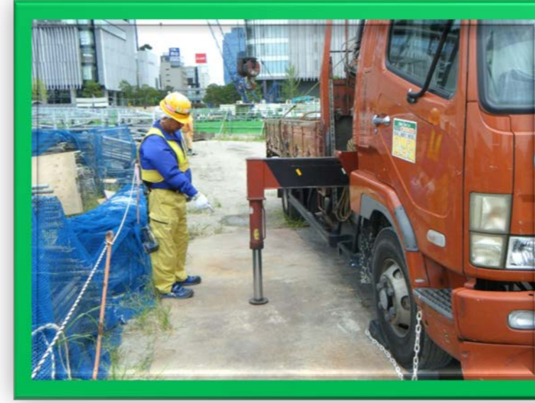
②アウトリガー下の養生（基本22mm以上の敷鉄板）
