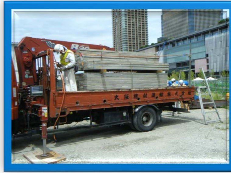
④親綱設置（地面より2m以上の作業）
