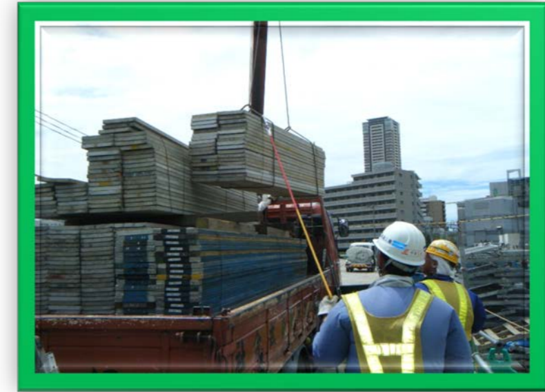
⑤介錯ロープ使用・吊荷直下の人払い
