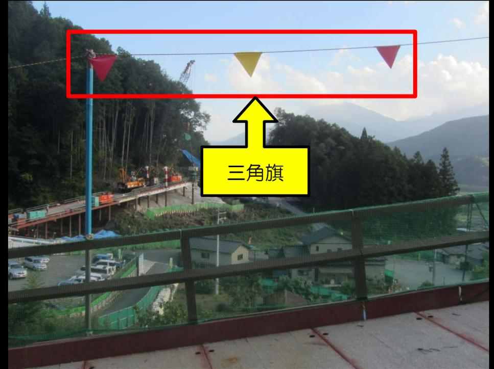
トラックの運転席から栈橋の防護柵の位置を確認できるように工夫した
