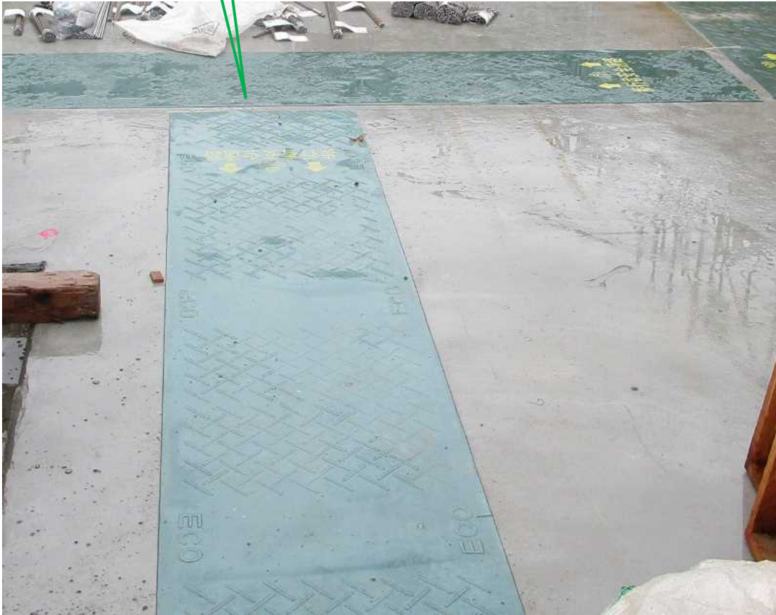
作業通路の見える化(拡大)
