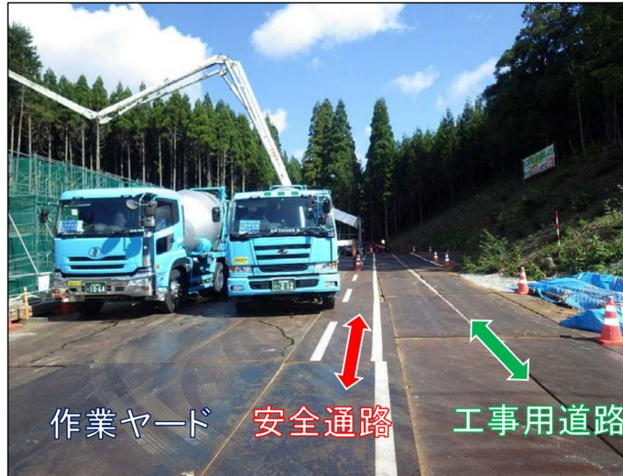
カラーコーンによる明示だけでは、大型車両の出入りなどにより一時的に撤去した際、作業区分や安全通路等が分からなくなるが、白線を引くことにより常に分かるようになる。
