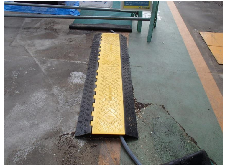
ホース収納後の通路の段差防止
