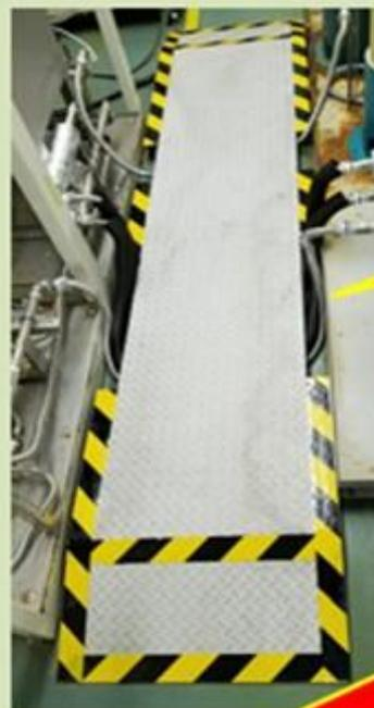
配管をスロープの下に潜るように設置する事で躓き、転倒を防止する
