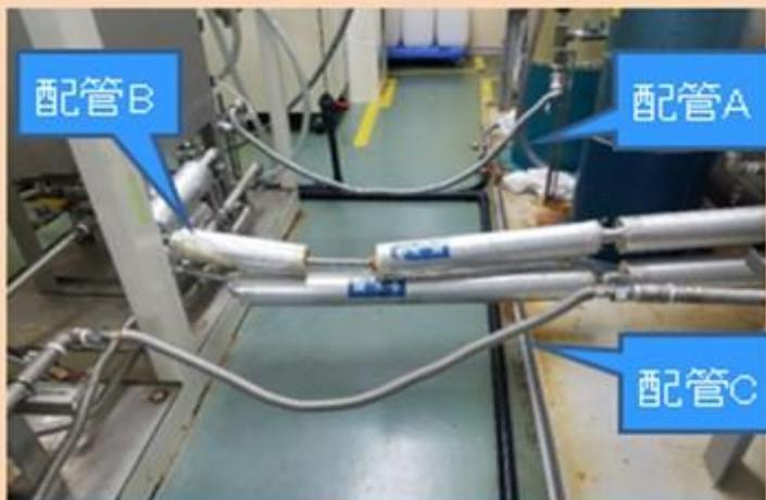
日常点検実施する際、足元に配管が乱雑に配置されている為、点検時に配管を跨ぐ事で躓き、転倒して怪我をする危険が大きい。
