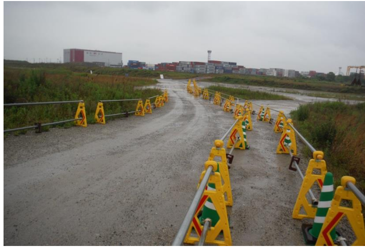
安全通路とダンプ通路
