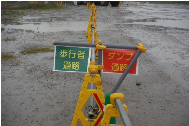
歩行者通路、ダンプ通路の明示
