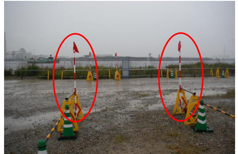
ダンプ通路の横断ヶ所の明示
