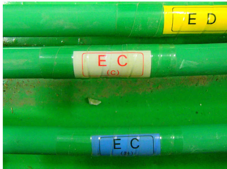
《布設ケーブルへの表示 (5m間隔)》
