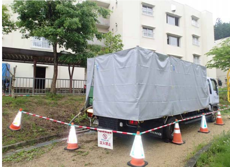
仮囲い・防音シート設置状況 (4t車搭載型コンプレッサ車)
