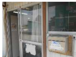
事務所外に設置した 「ヒヤリ ハット投函箱」
