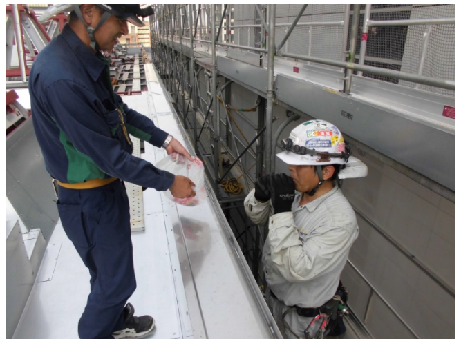
熱中症対策ゼリーを現場巡回時に配布、注意喚起を行う(特に屋外での作業者)
