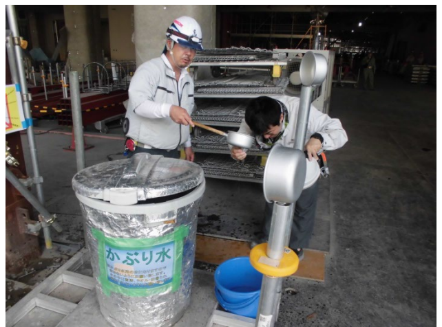
外部作業員用かぶり水(氷入り)を1階に設置 (防暑垂れは、濡らすと効果的である)
