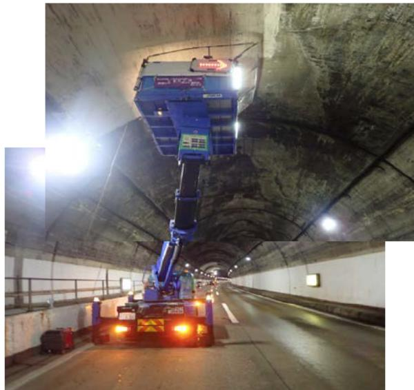
供用中のトンネルにおいて、足場を必要とする部位での作業には、高所作業車を使用する事が一般的で、中央部付近の作業を行う場合はバスケットがセンターラインからはみ出すヒューマンエラーにより、特に大型の一般車両等と接触するリスクがあつた。
