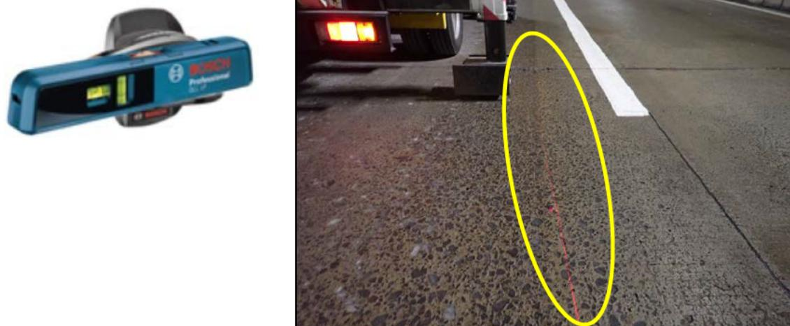
バスケットのセンターライン側にレーザーポインターを設置し、路面のセンターラインをはみ出していないかをバケット上から確認する事にした。一般的なレーザーポインターは点状に照射されるものに対し、線状に照射されるものを使用する事で、バケット上からの視認性が向上し、バスケットのはみ出し確認のヒューマンエラーの発生が低減された。
