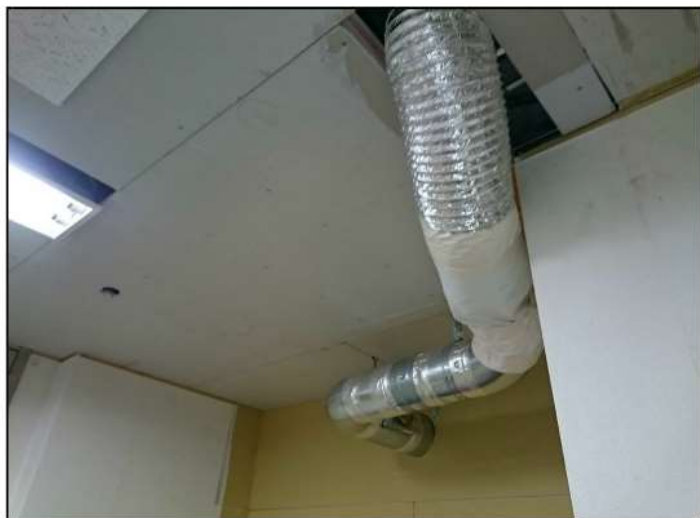
天井下り壁施工状況
