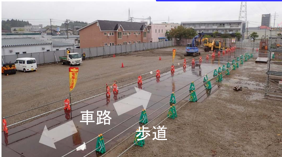
バリケードによる歩車分離 (通路には緑のバリケードを使用)
