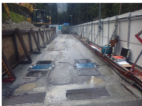
トラックスケール設置
